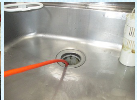
住居内の排水管高圧洗浄
