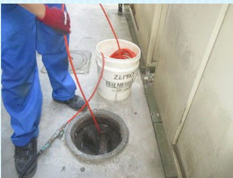
建物外の排水管高圧洗浄
