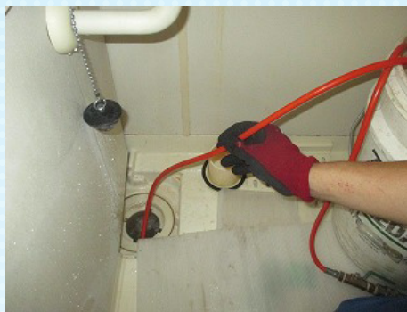
住居内の排水管高圧洗浄
